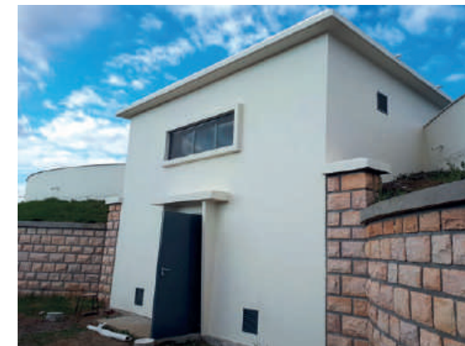
Réservoir de Cébazat - Après
