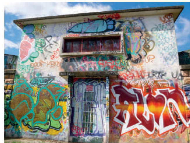
Réservoir de Cébazat - Avant
