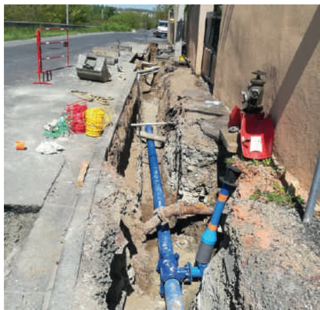
Renouvellement de conduites et de branchements d'eau potable.
