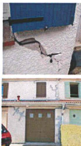
Mécanismes et conséquences des tassements différentiels par retrait-gonflement des sols argileux
